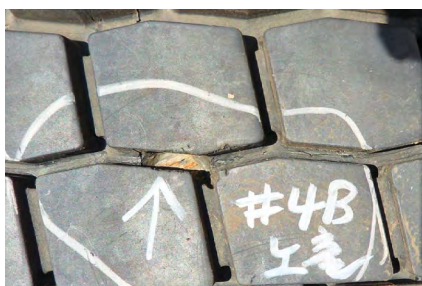
<Fissure des rainures de type 1>
