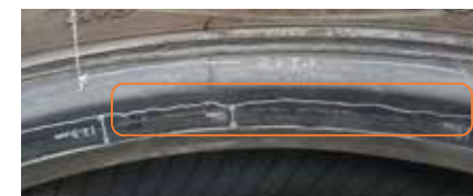
Trace de pose non-uniforme de la jante (ligne blanche)
